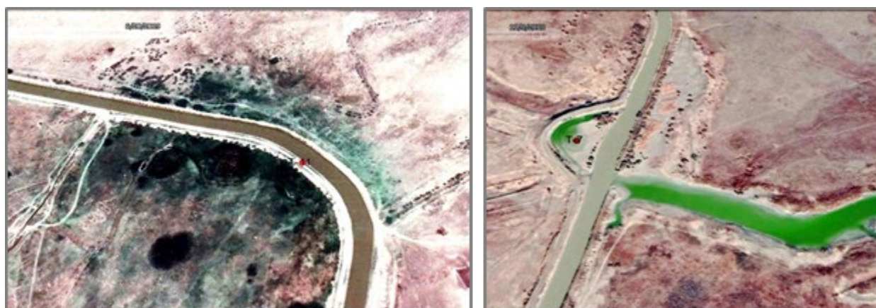
Рис.16. Затопление и подтопление смежных с ТМК земель, Т-11 (слева) и затопление земель при пересечении ТМК и р. Арыстанды, Т-7 (справа)
